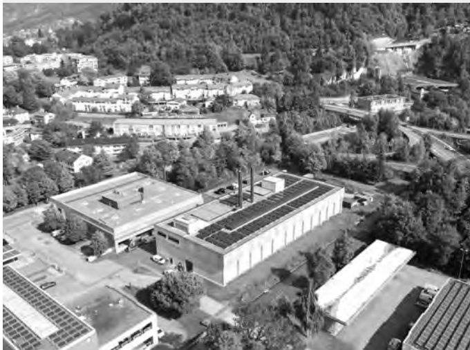
Neues Heizwerk Nahwärme Weidach © illwerke vkw
